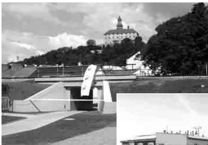
podchody pod tratí
