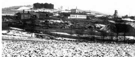
Staveniště tvrze Dobrošov a srub N-S 72. Foto 1938
