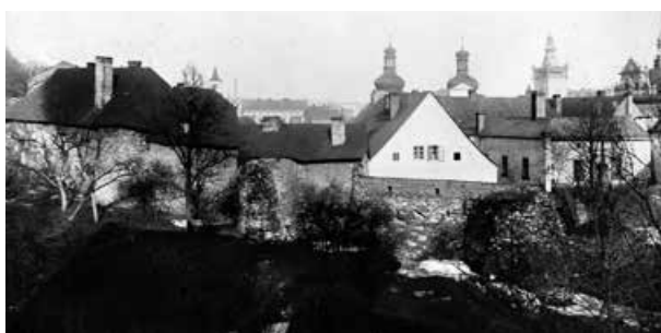
Městské hradby za čp. 66 a 67 zbořené v r. 1980. Foto 1910
