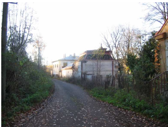
Obr. 57. Současný stav lázní
